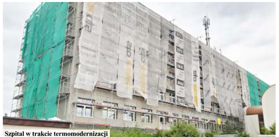
Szpital w trakcie termomodernizacji
