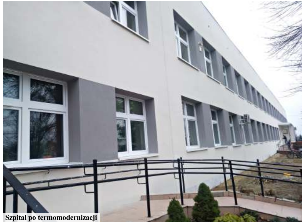
Szpital po termomodernizacji
