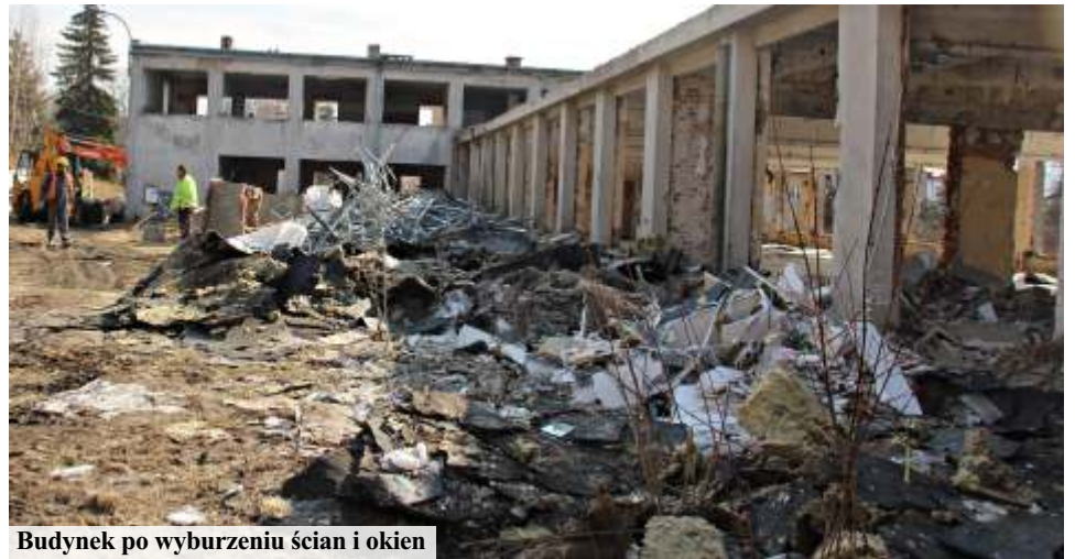
Budynek po wyburzeniu ścian i okien
