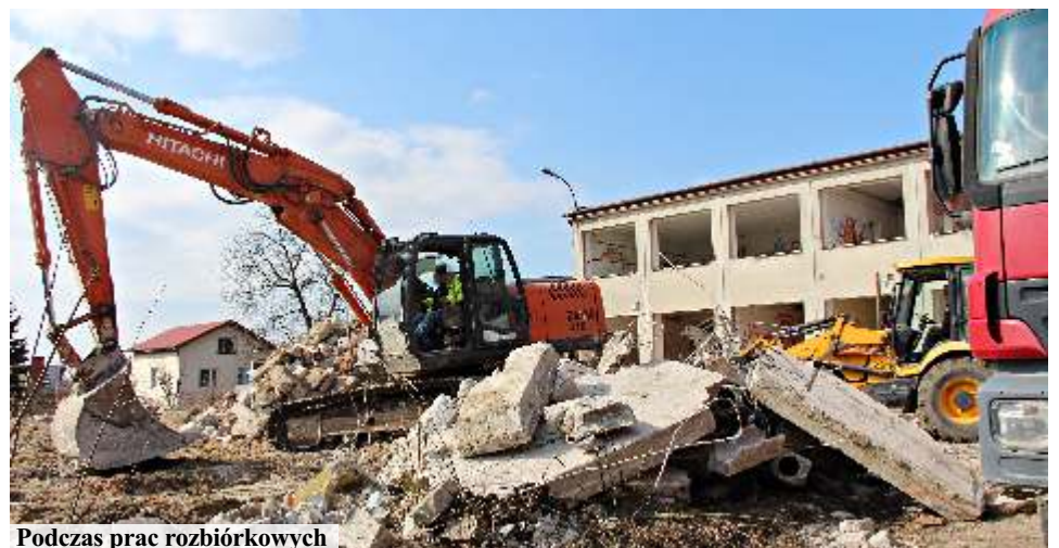
Podczas prac rozbiórkowych
