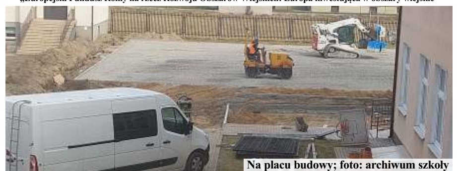
Na placu budowy; foto: archiwum szkoły
