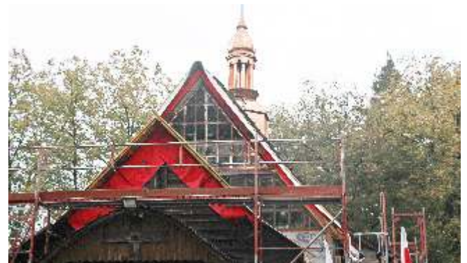
Remontowany kościół w Momotach Górnych
