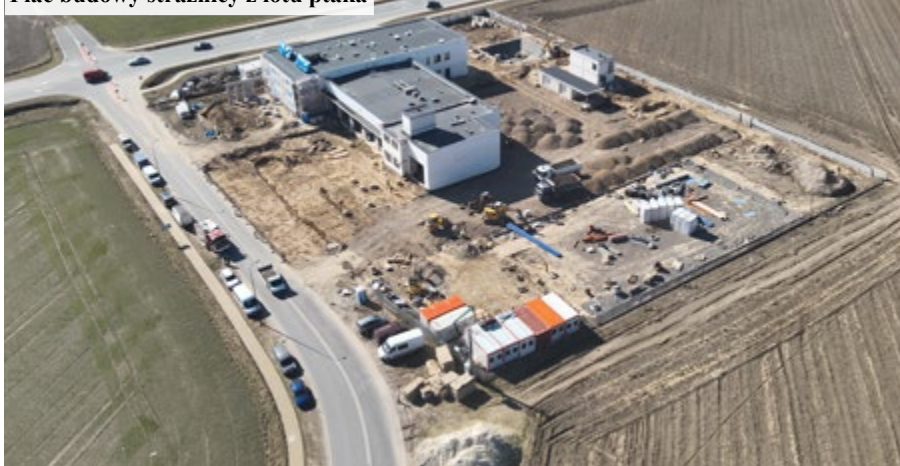
Plac budowy strażnicy z lotu ptaka
