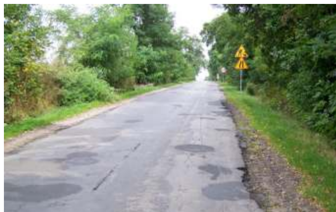
2009 r.: odcinek Rataj - Zdziłowice przed modernizacją
