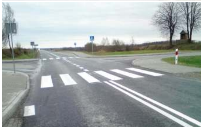
2011 r.: odcinek Rataj - Zdziłowice po modernizacji
